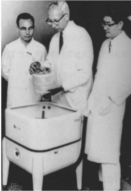
Рисунок 2.8 – Віллем Колф (у центрі) та штучна нирка пральної машини [1]
